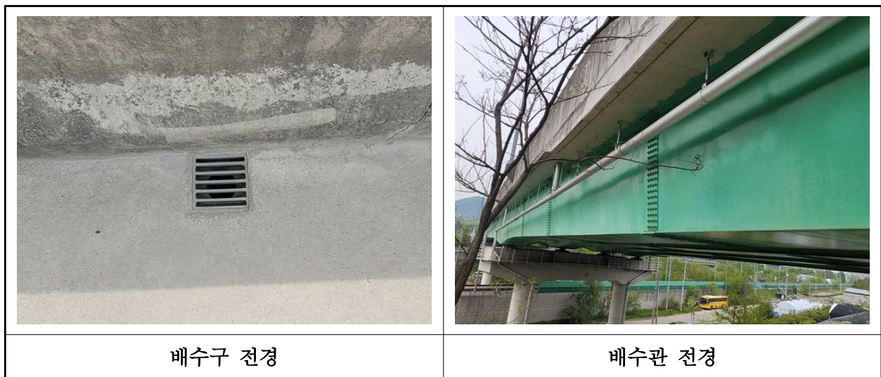
【사진 6.3.24】 배수시설 전경
