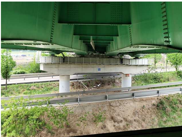
교각 P4 상태현황
