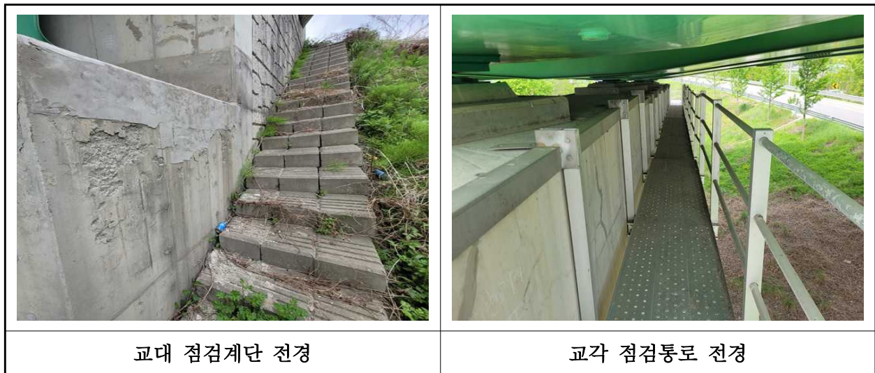
【사진 6.3.28】 교량 점검시설 전경
