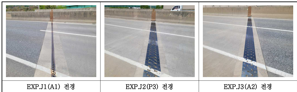
【사진 6.3.19】 신축이음장치 전경
