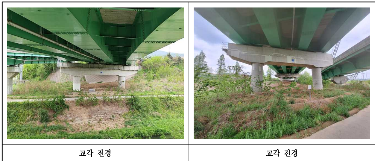
【사진 6.3.11】 교각 전경
