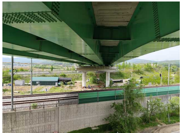
교각 P5 상태현황
