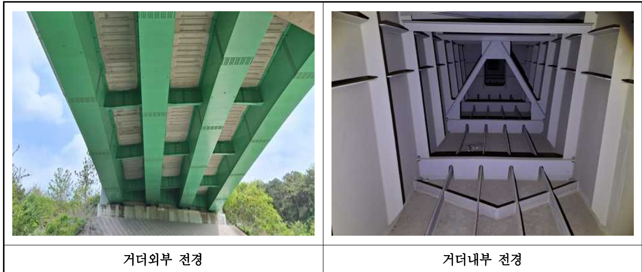
【사진 6.3.4】 거더 전경
