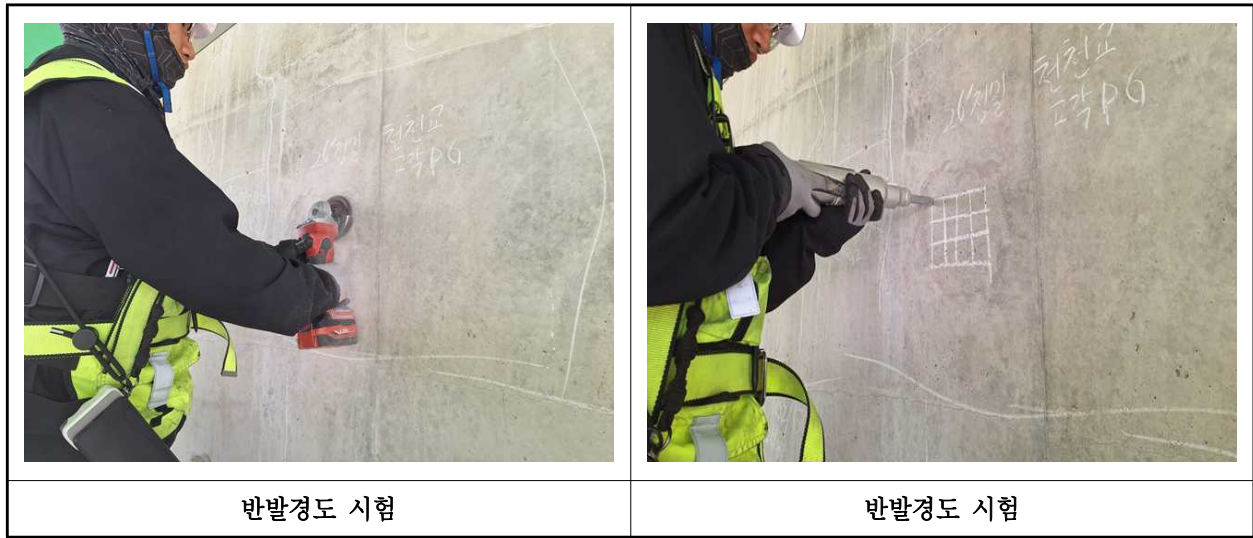
【사진 6.4.2】 반발경도시험 현장사진
