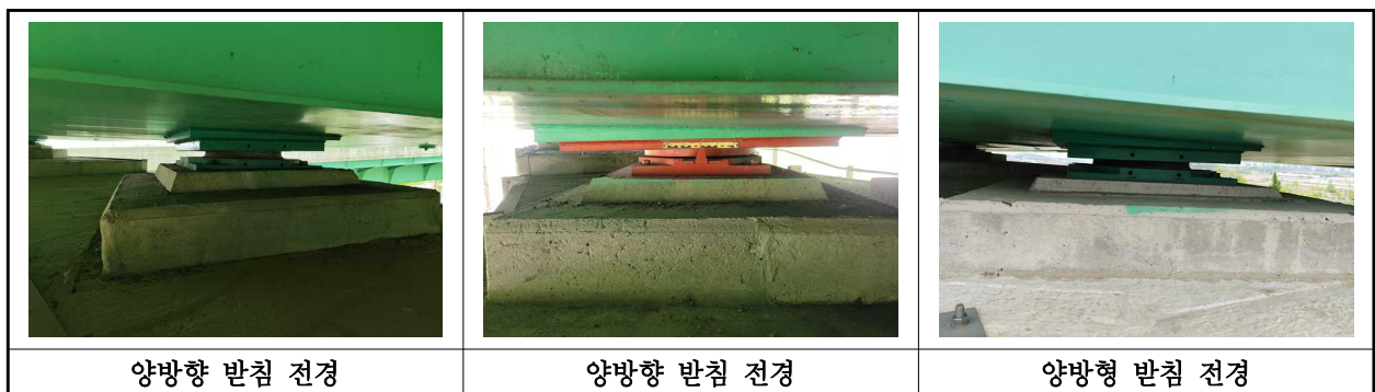
【사진 6.3.15】 교량받침 전경
