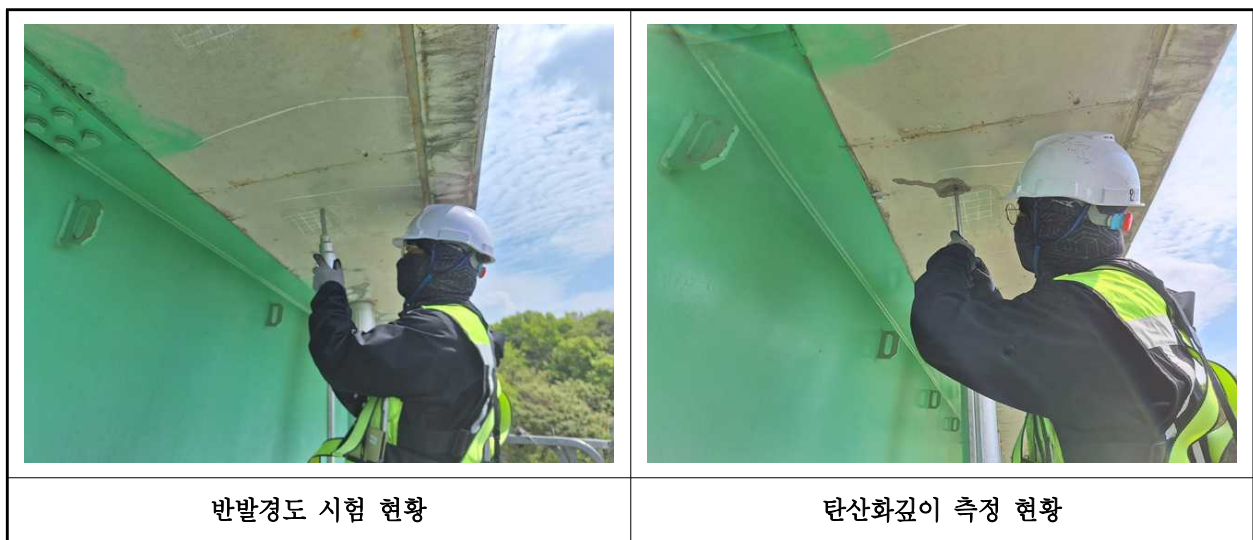
【사진 6.4.1】 콘크리트 내구성조사 현황
