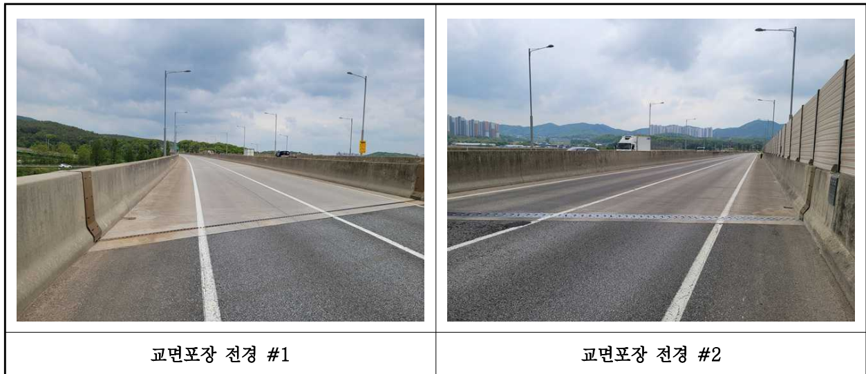
【사진 6.3.22】 교면포장 전경
