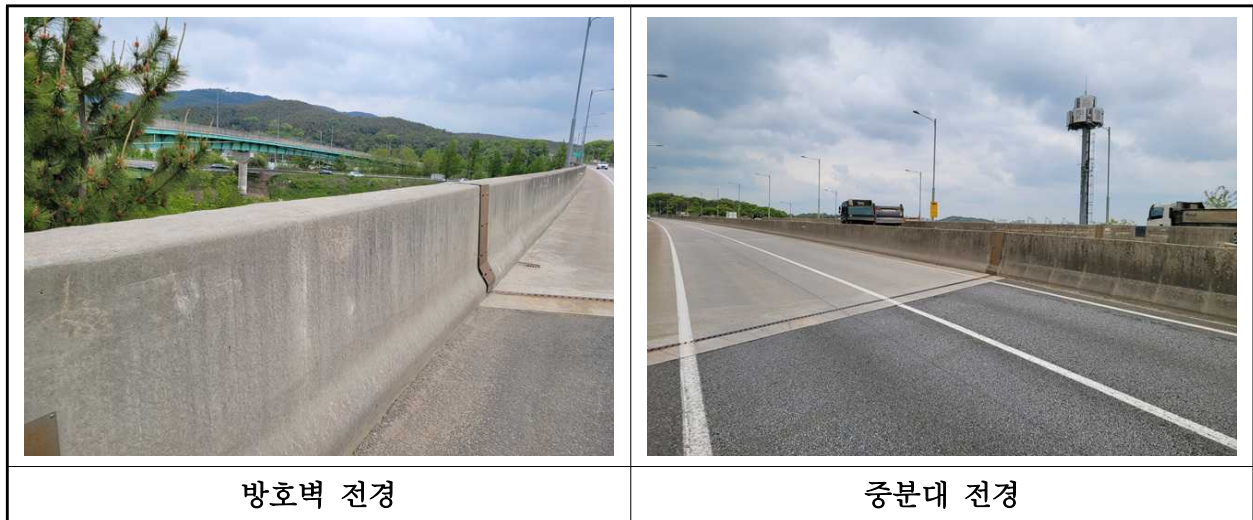
【사진 6.3.26】 방호벽 및 중분대 전경
