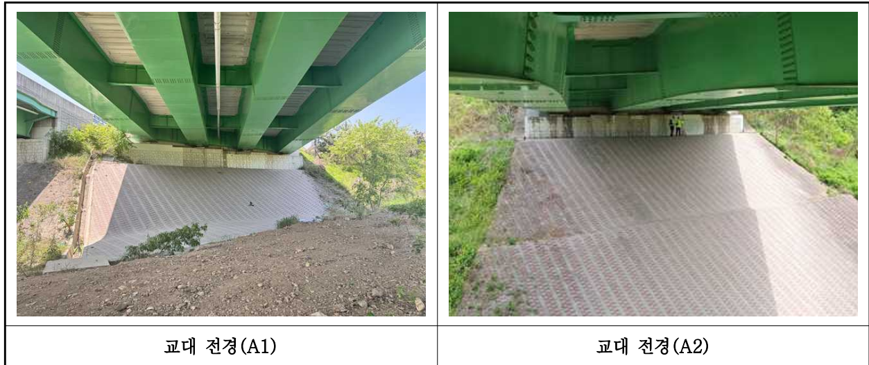
【사진 6.3.8】 교대 전경
