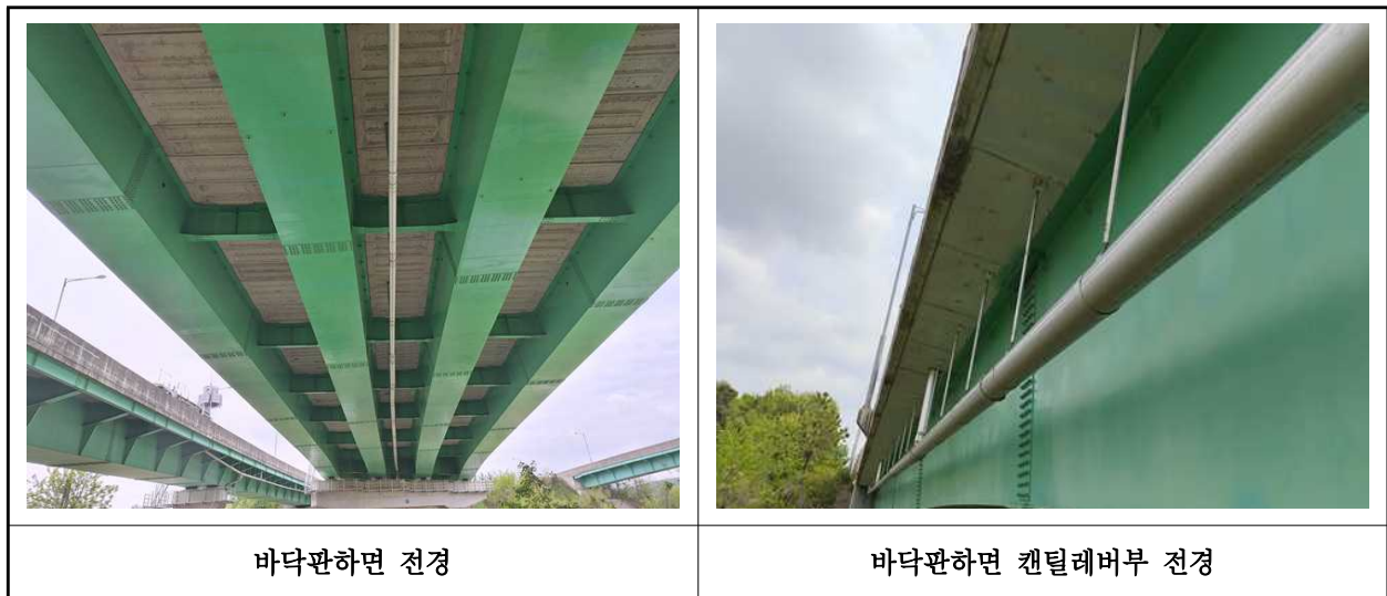
【사진 6.3.2】 바닥판하면 전경
