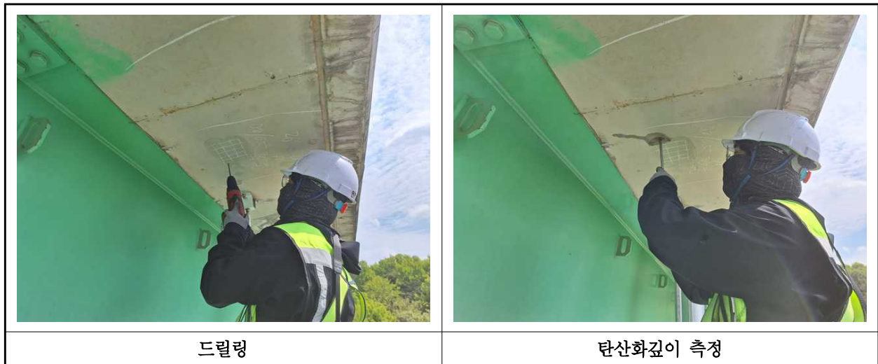
【사진 6.4.3】 탄산화 깊이 측정 현장사진
