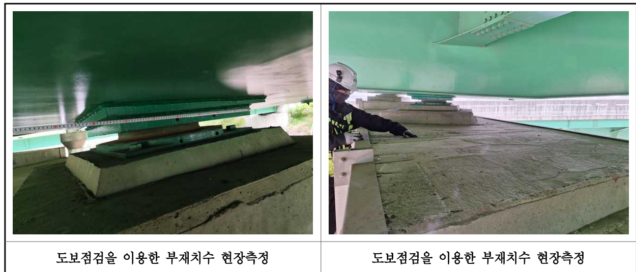
【사진 6.2.3】 부재 현장측정 전경
